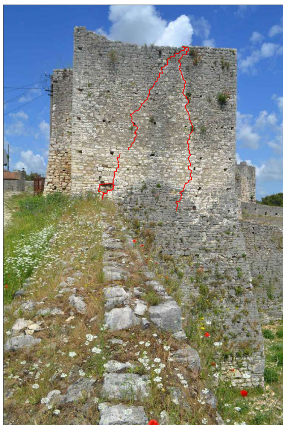
Fig. 67: Zgavra dhe krisje vertikale të muraturës së gurit në kullën Nr.23, pamja jugore. Foto: Dritan Çoku, dt.18.05.2021, DRTK-Berat.
