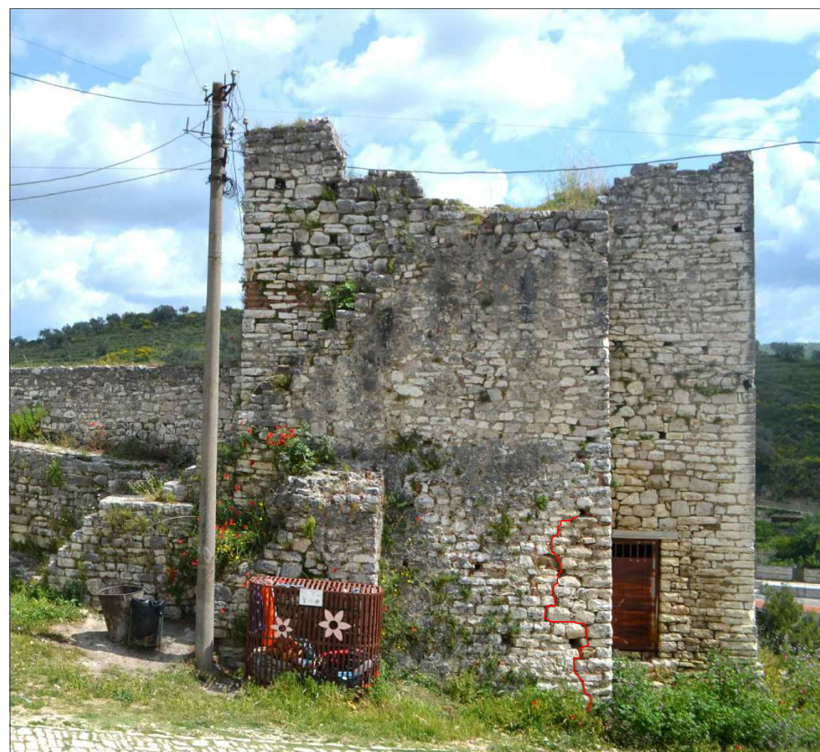
Fig. 68: Krisje vertikale në pjesën e poshtme të qoshes së shkallës, në kullën Nr.23, pamja perëndimore. Foto: Dritan Çoku, dt.18.05.2021, DRTK-Berat.
