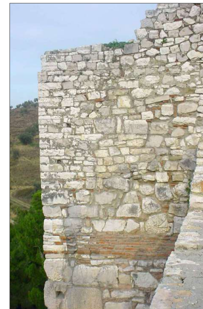
Fig. 42: Kulla Nr. 1 - Pas restaurimit. Foto: DRTK-Berat, 12.11.2004.
