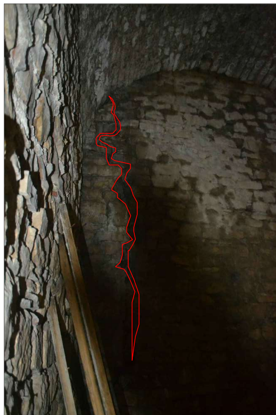
Fig. 69, 70: Pamje hollësi nga çarje në faqet e brendshme të muraturës së kullës Nr.23. Foto: Dritan Çoku, dt.18.05.2021, DRTK-Berat.
