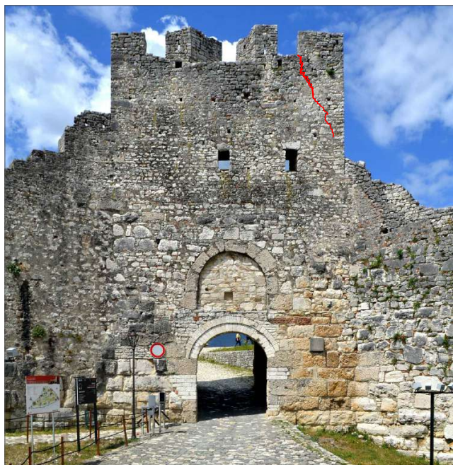
Fig. 71: Krisje vertikale në qoshen verilindore të kullës Nr.24, e cila rrezikon shkëputjen e qoshes së sipërme të murit (Pamja lindore e kullës Nr. 24). Foto: Dritan Çoku, dt.17.05.2021, DRTK-Berat.
