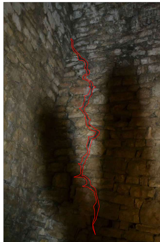
Fig. 69, 70: Pamje hollësi nga çarje në faqet e brendshme të muraturës së kullës Nr.23. Foto: Dritan Çoku, dt.18.05.2021, DRTK-Berat.
