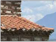
P6 Riparim, zevendesim, hidroizolim Riparim i tjegullave te demtuara, heqja e tjegullave greke dhe vendosja e tjegullave te vendit si dhe hidroizolimi i siperfaqes. Riparimi i strehes se Narteksit.
