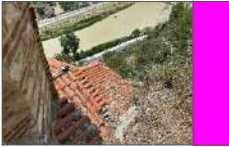
P3 Zberthim, zevendesim Zberthimi i te gjithë mbuleses se tjegullave greke dhe zevendesimi i tyre me tjegulla vendi
