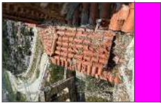
P9 P10 Zberthim, zevendesim Zberthimi i te gjithë mbuleses se tjegullave greke dhe zevendesimi i tyre me tjegulla vendi
