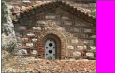
P11 P12 Pastrim, rigurim Pastrim i pjesshem se strehes se demtuar, riparimi i saj dhe mbulimi me tjegulla vendi Clirimi nga dherat , bimesia e ullukut e realizuar me tjegulla per shkarkimin e ujrave te shiut
