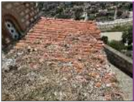
P2 Zberthim, zevendesim Zberthimi i te gjithë mbuleses se tjegullave greke dhe zevendesimi i tyre me tjegulla vendi
